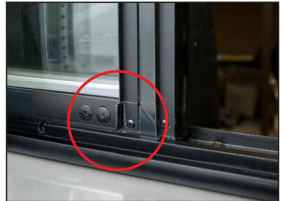
Fig. 2. Le verrou de porte est en position fermée (dégagé de l'encoche).
